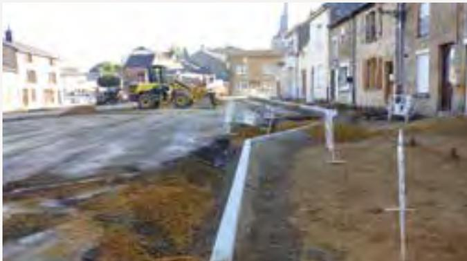
Implantation de gaines pour l'installation d'un point électrifié au centre de la place.
