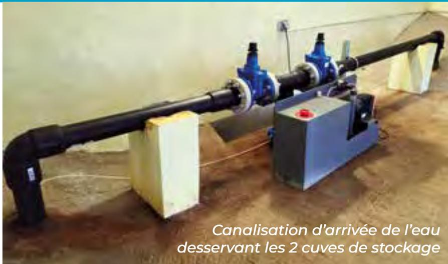
Canalisation d'arrivée de l'eau desservant les 2 cuves de stockage
