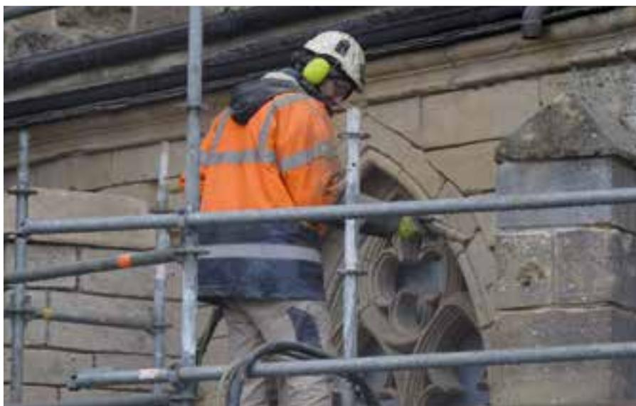
Nettoyage des pierres par hydrogommage basse pression (2.5 bars) et rinçage à l'eau.
