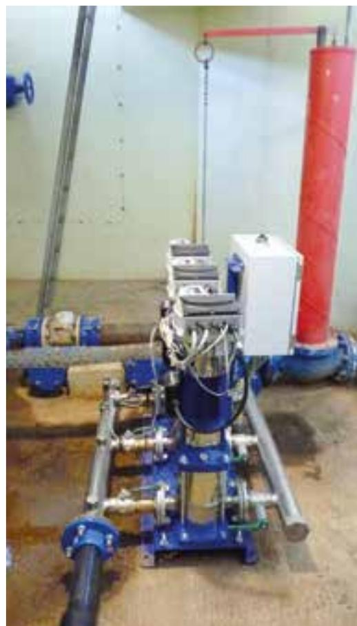
La nouvelle installation plus compacte est composée de 3 pompes fixées sur un châssis métallique. Elles sont raccordées par des conduites et brides en inox au circuit de distribution en eau potable.
